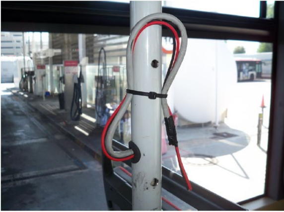
Imagen 15. Agujero de salida cables validadora.
