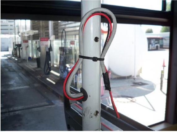
Imagen 15. Agujero de salida cables validadora.
